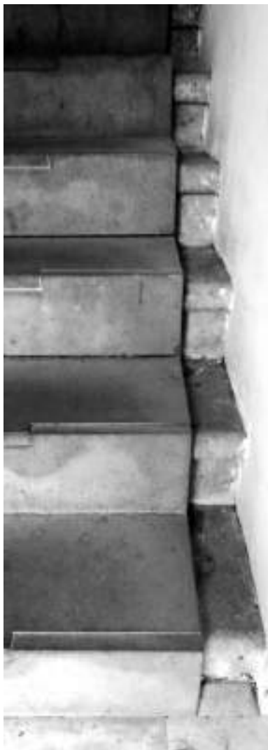
Restauro del monastero dei Benedettini a Catania. Dettaglio scala. Foto di Alberto Ulisse, 2019.
